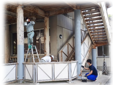
有志による柱のペンキ塗り
